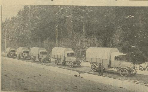
Lastzüge bis 10 Tonnen Tragkraft
