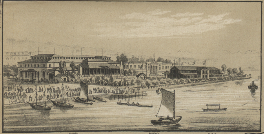
Tonhalle. Ausstellungsbau. Festhalle.
