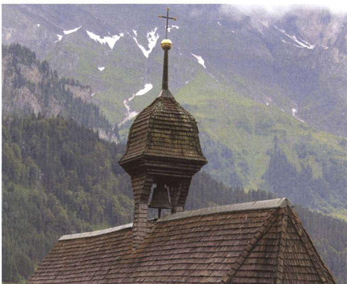
Das Schindeldach der Friedhofskapelle beim Kloster bietet Flechten einen speziellen Lebensraum.
