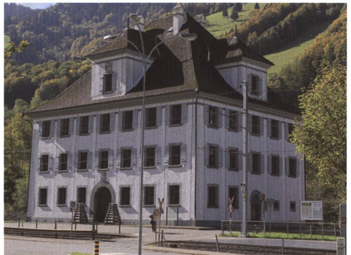
Das Herrenhaus am südlichen Eingang zum Oberen Engeltal
