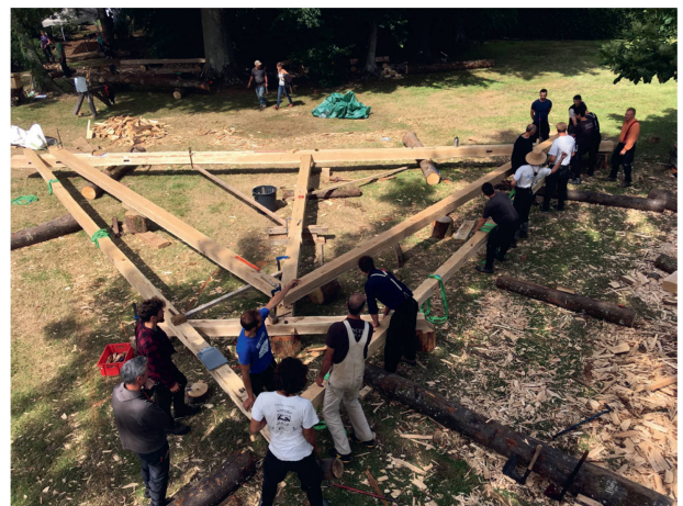
3 Assemblage de la ferme 7 sous la direction de Florian Carpentier. Mesnil-Geoffroy, Seine-Maritime, juillet 2020 (photo François Calame).
