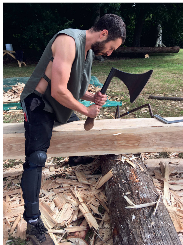
2 Équarrissage à la doloire de chêne frais pour l'expérimentation de la ferme 7, par le charpentier Léo Rousseau. Mesnil-Geoffroy, Seine-Maritime, juillet 2020 (photo François Calame).
