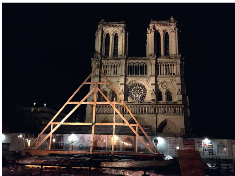
4 Levage expérimental de la ferme 7 reconstituée sur le parvis de la cathédrale Notre-Dame de Paris, 20 septembre 2020 (photo François Calame).
