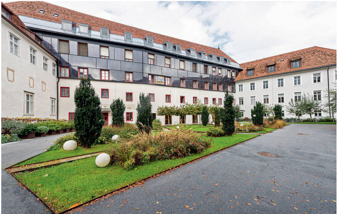
3 Graz (Autriche), couvent des franciscains, façade historique dotée de panneaux solaires (photo Jörgler).
