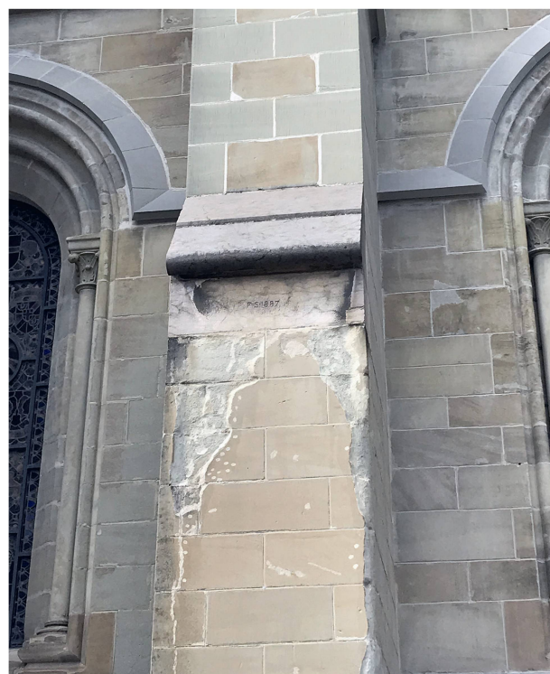
2 Arc-boutant sud dont les éléments constitutifs ont été remplacés lors des deux dernières restaurations en date : travaux de 1887 menés par Henri Assinare pour la retraite talutée, le larmier et les assises inférieures ; travaux de 2001-2010 par Christophe Amsler architecte pour la partie au-dessus de la retraite en calcaire (photo Amsler Dom arch., 2021).
