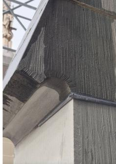
Coulisse insérée dans le joint inférieur du larmier.
