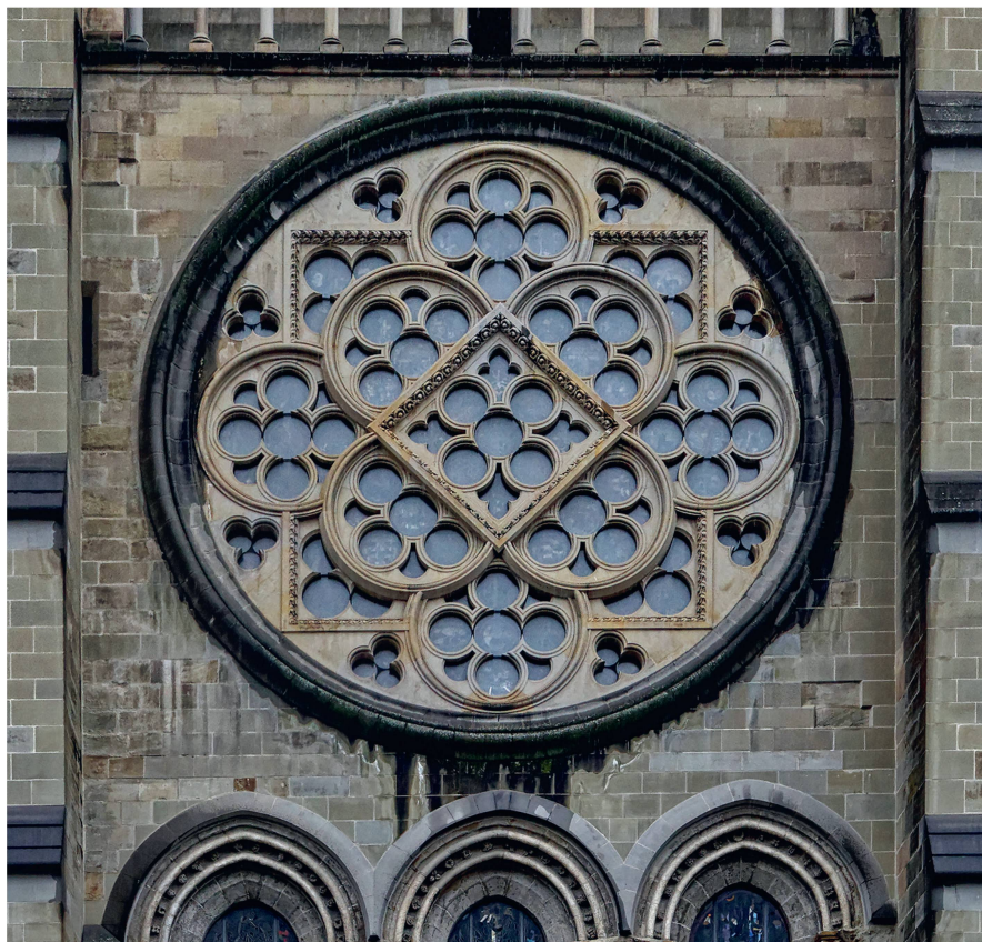
12 Rose de la cathédrale sous un régime de pluie installée. L'eau ruisselle sur les tores dans la partie supérieure et sur la façade sous la rose (photo Rino Sarà, 2019).
