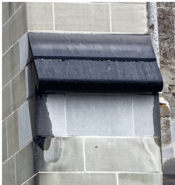
4 Retraite talutée d'un contrefort sous un régime de pluie installée. L'eau ruisselle sur le dos de la retraite, mais également sur les joues et les assises inférieures formant les bavures latérales, nommées fort à propos « moustaches » par Viollet-le-Duc (photo Rino Sarà, 2019).
