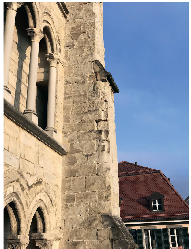
15 Tour du transept nord, retraite talutée avec dégradation angulaire du contrefort nord-ouest, Jean-Bernard Sinner (?) (photo Amsler Dom arch., 2021).
