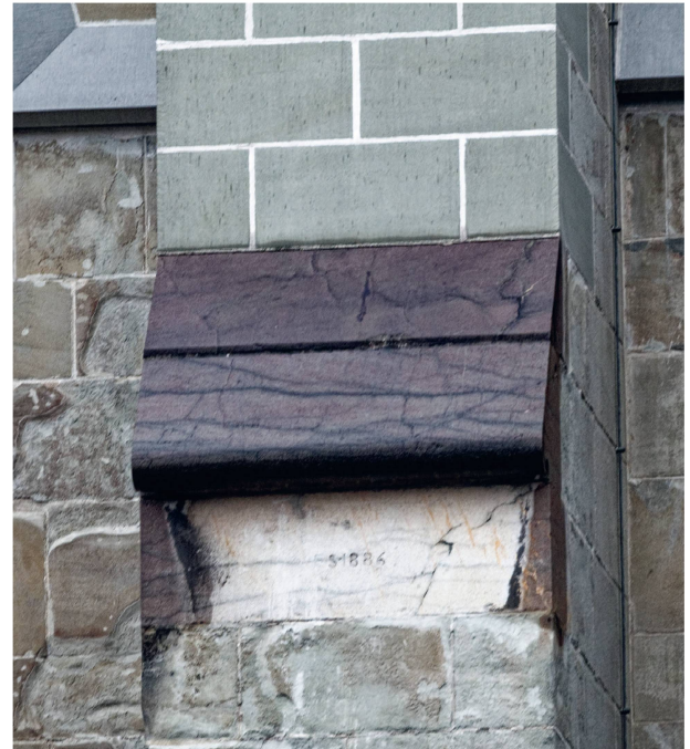
14 Contrefort de bas-côté, retraite à bec, Henri Assinare, 1886, avec débordements latéraux du talus, effet goulot au cavet et, consécutivement, altération angulaire du contrefort inférieur (photo Rino Sarà, 2019).
