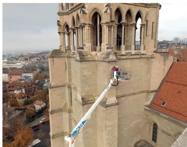
3 Les cibles nécessaires à l'orientation et au géoréférencement des clichés photogrammétriques ont été placées en divers endroits des façades à l'aide d'un camion nacelle.
