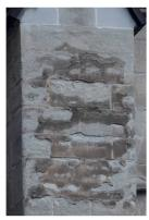
4 Photographies prises sous pluie. À gauche: mise en évidence d'infiltrations d'eau ressortant dans les joints de façade provenant probablement des joints du glacis de toiture. Observation en conditions de pluie verticale de faible intensité. À droite: les plaques déjà vulnérables semblent les plus exposées à la pluie. Observation réalisée en conditions de précipitation verticale de faible intensité.
