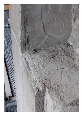
2 L'enlèvement d'un bloc destiné à être remplacé laisse apparaître, sur la tranche des blocs périphériques, une déstructuration de 2 à 3 cm formée sous les plaques.
