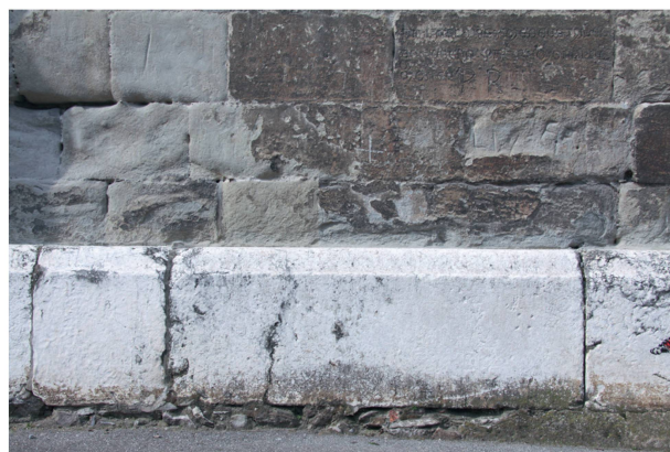
1 Cathédrale de Lausanne, dégradation de la molasse au niveau du chœur (Photo Bureau Christophe Amsler).
