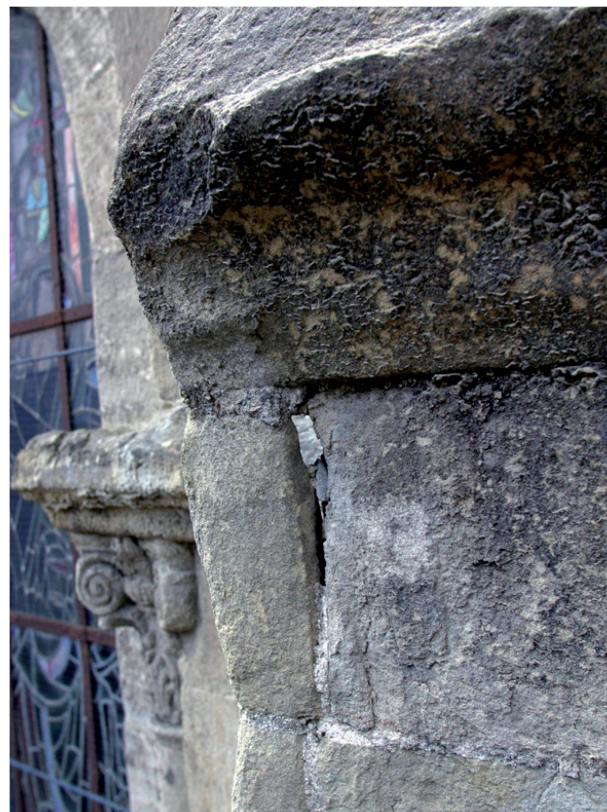
1 Cathédrale de Lausanne, dégradation de la molasse au niveau du chœur (Photo Bureau Christophe Amsler).
