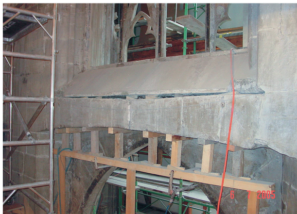
4 Redressement de l'arc de décharge affaissé au-dessus de la porte sud à la travée 4 sud (TS4) (© Stanislas Rück, Fribourg).
