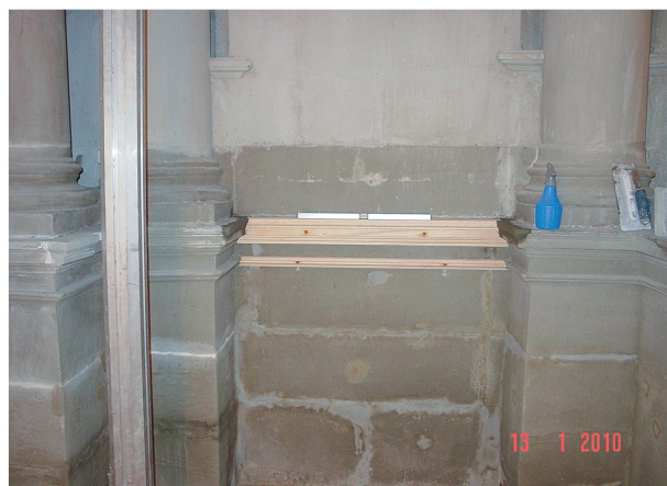
5 Réparation d'une corniche intérieure au moyen de profils en bois avant badigeon en gris molasse à la travée 2 sud (TS2) (© Stanislas Rüch, Fribourg).
