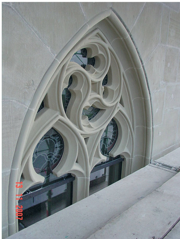
2 Baie et remplages du collatéral à la travée 3 sud (TS3) avec badigeon de protection et faux-joints (© Stanislas Rück, Fribourg).
