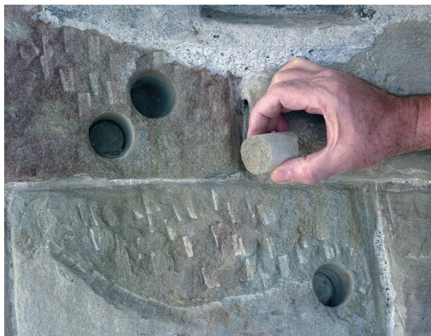
5 Purges et remise en place de la substance des carottages en 2007 (Documentation photographique de la Ville de Genève, Photo Claudio Merlini).
