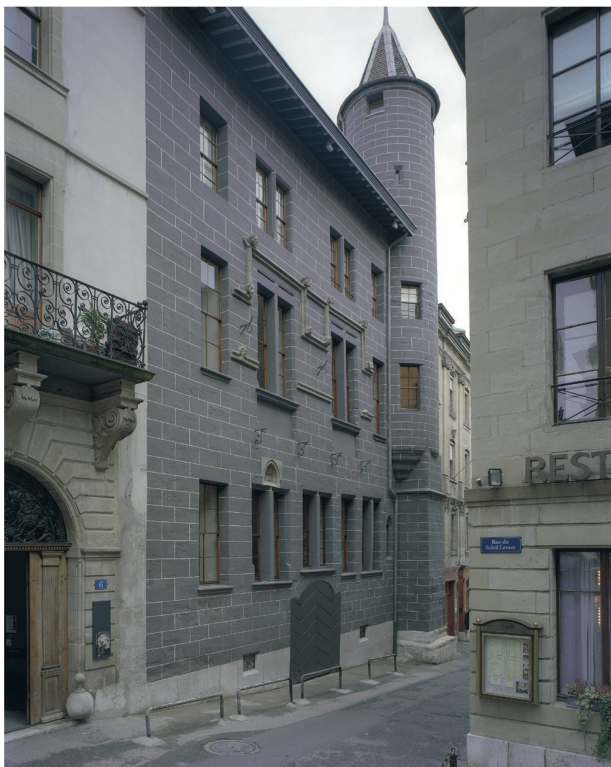
6 La façade principale après la restauration en 2007 (Documentation photographique de la Ville de Genève, Photo Claudio Merlini).
