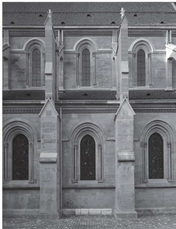
6 Façade nord de la cathédrale (travées c-d-e) : état après les récents travaux de réhabilitation (Photo Claude Bornand, Lausanne, 2010).
