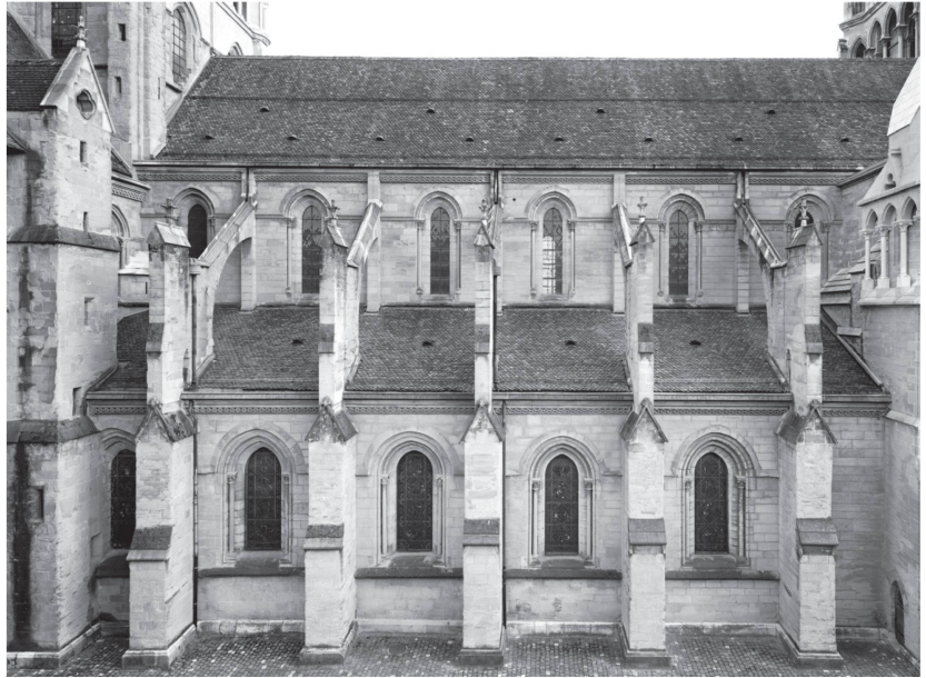
1 Façade nord de la cathédrale de Lausanne, état avant les récents travaux de réhabilitation: variété des emplois de la pierre (Photo Claude Bormand, Lausanne, 2000).
