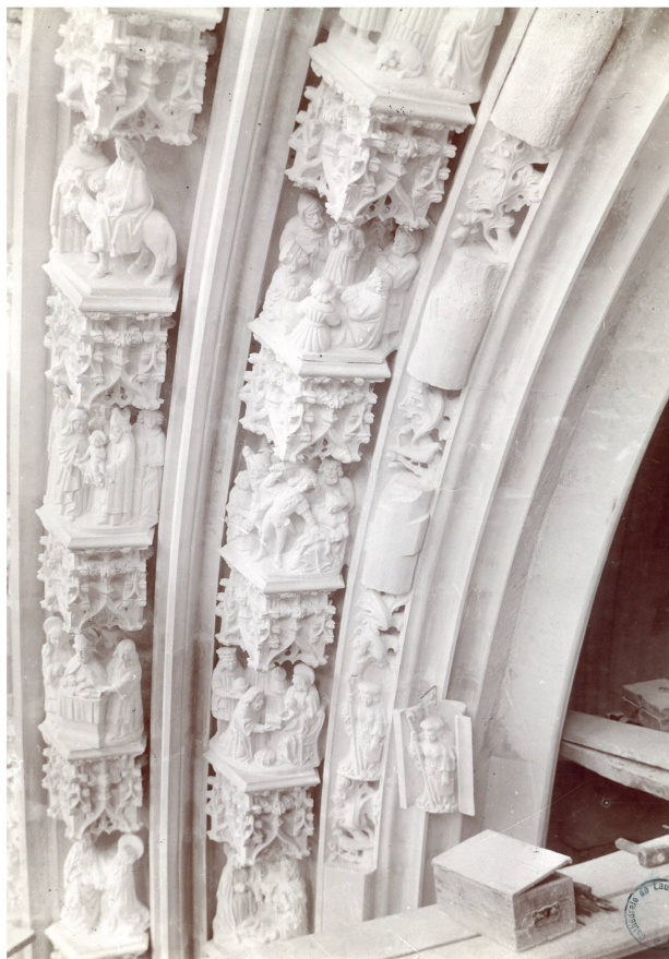
2 Portail Montfalcon, extérieur, pendant les travaux de reconstruction, fin 1898. Sculpture des figures des voussures (côté gauche) en calcaire de Lens. Photographie de John Curchod (ACV, SB 52 Aa/11/7).
