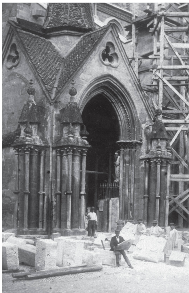
2 Portail peint, vue générale, côtés sud-ouest, après la démolition de l'arc-boutant en automne 1880. Les parpaings latéraux sont encore en place. Photo de chantier avec au premier plan, assis : Henri Assinare ? (ACV, SB 52 Aa/22/10).
