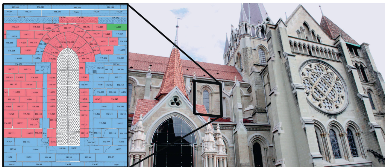
5 Exemple de cartographie archéologique d'un élément de la façade sud.
