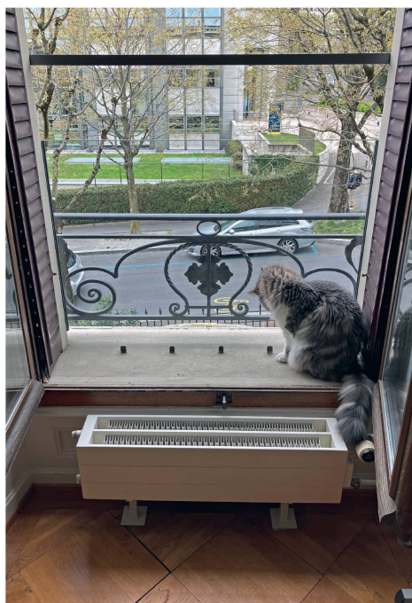
2ab Les propriétaires ont choisi d'ajouter un verre et une barre transversale au garde-corps d'origine, alors qu'une chaînette au niveau de la traverse supérieure permettait de garantir la sécurité des jeunes enfants (photos Martine Jaquet).
