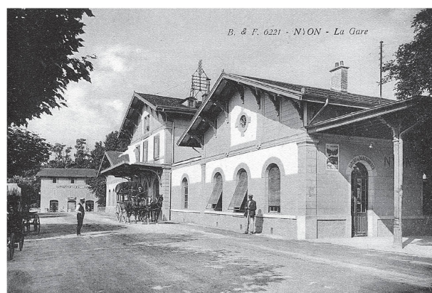
1 Gare de Nyon. Carte postale, après 1900. Bâtiment en maçonnerie avec corps principal datant de 1857 à trois niveaux d'élévation, avec bardage de bois, et toiture à deux pans reposant sur des bras-de-force chantournés. Les toitures latérales sont plus tardives, mais reprennent le même principe (AC Nyon).
