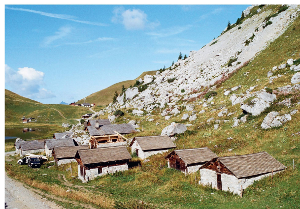
4 La Montagne d'Aï vue de l'est. Les écuries allient pierres et bois. Le chalet appuyé à son rocher se reconnaît à sa cheminée. En été 2010, les taviillonneurs entretiennent les toitures (photo Denyse Raymond).
