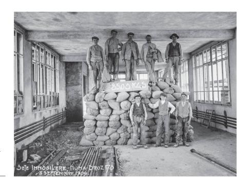
7 René Chapallaz, photographie d'essai de surcharge de plancher dans la fabrique Clairemont, 1909, négatif souple transformé en positif par Photoshop, 16 x 21 cm (VCH-BVFSP RC).
