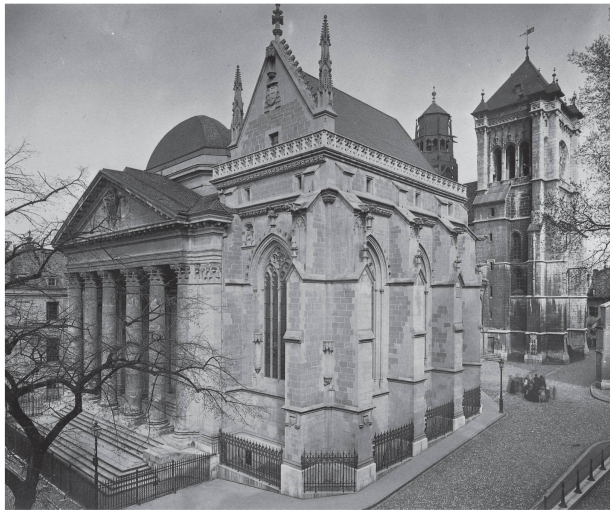
1 Chapelle des Macchabées à Genève, état vers 1890, après la restauration de 1879-1882 et avant la dérestauration de Frédéric Gilliard en 1939 (BGE, CIG, inv. VGN 13x18 5443, photo anonyme).
