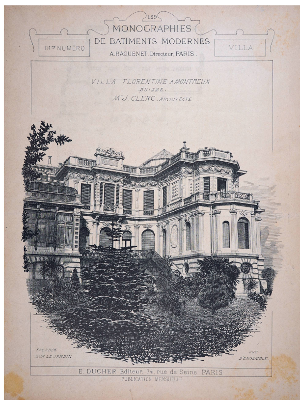
1 Montreux, Villa Florentine, façades sur le jardin (AM, PP 87, fonds Charles Riolo, B-2-d-26-a).
