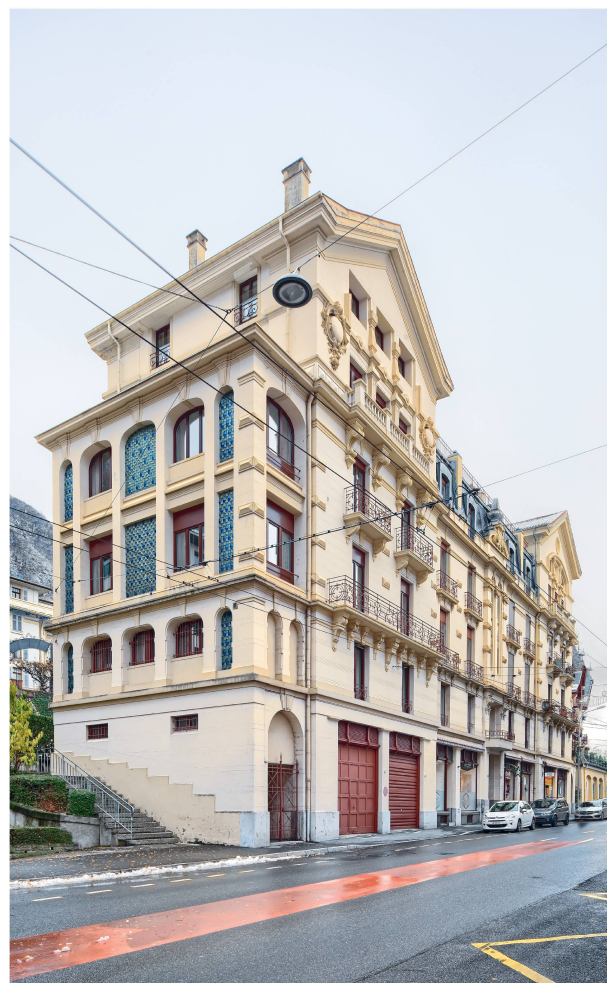
2 Territet, Les Jumelles, façade ouest animée d'un vaste semis de briques Falconnier (photo Régis Colombo, 2017, Château de Nyon).
