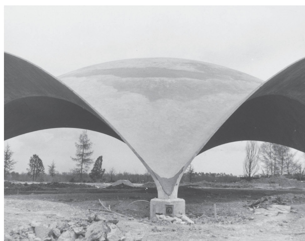
7-8 Centre de jardinage Wyss à Zuchwil (SO), 1961 (gta Archiv, EPFZ, fonds Isler, dossier 217-9).
