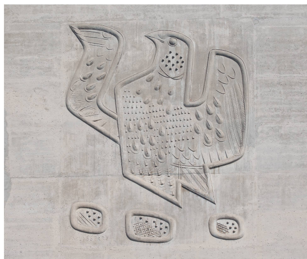
1 André Lasserre, Oiseau , 1953, béton franc de coffrage, 6 x 4,5 m, Collège du Belvédère, Lausanne. Coffrage en bois assemblé, relief taillé à la main, coulé avec le mur en béton franc de coffrage. Architecte Marc Piccard (Collection d'art de la ville de Lausanne, photo Kevin Seisdedos).
