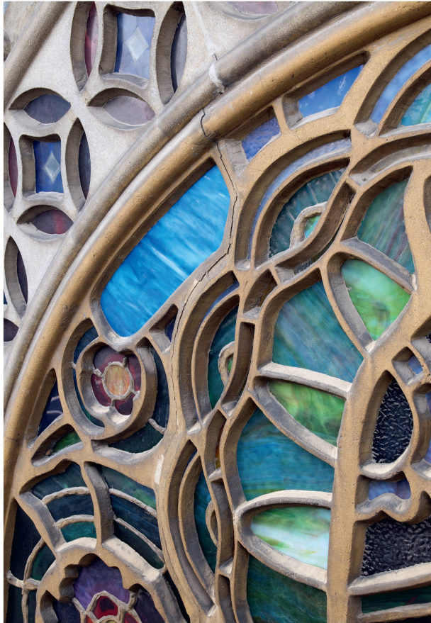
1 Richard Arthur Nüscheler, « fenêtre de pierre », verre et pierre artificielle armée, église Sainte-Marie de Saint-Gall-Neudorf, façade sud, 1917-1918. Vue intérieure et vue extérieure (détail) (photos Sophie Wolf).
