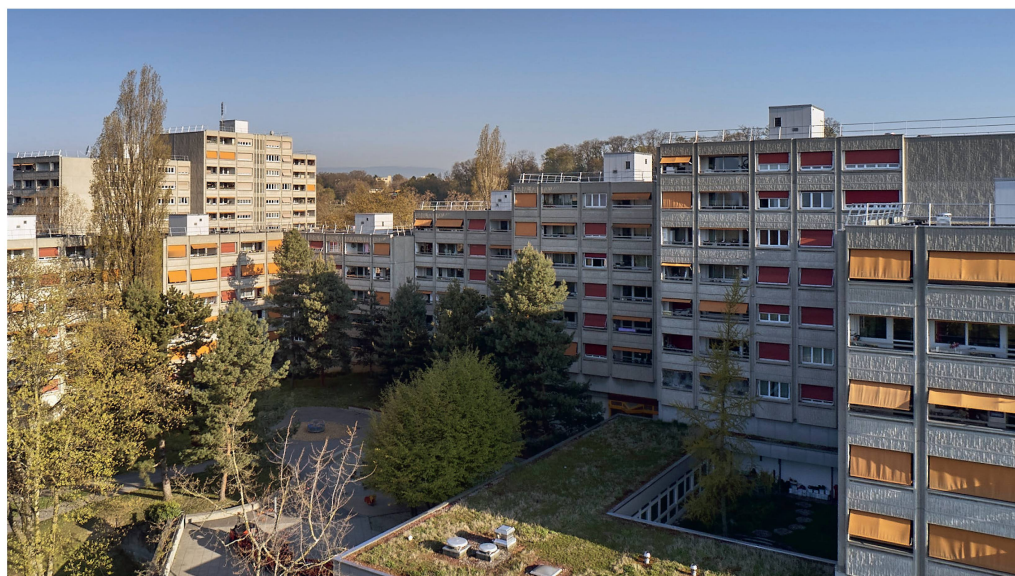
11 Vue aérienne des aménagements extérieurs et de l'arborisation (photo Jeremy Bierer, 2021).
