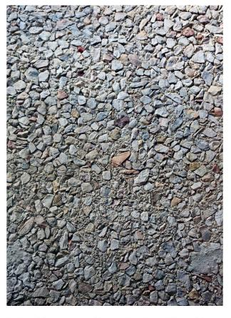
**9** Détail d'un panneau préfabriqué en béton lavé du Valentin (photo Aline Jeandrevin, 2019).
