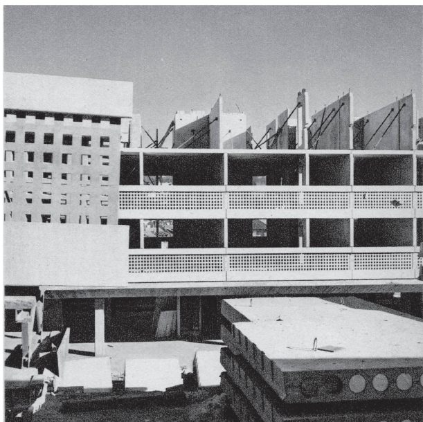
1 Quartier de l'Ancien-Stand, 1963-1965, chantier de l'immeuble sud, dont le gros-œuvre a été assemblé en 44 jours entre novembre 1963 et mars 1964 (Habitation 36, 1964, 7, p. 29).
