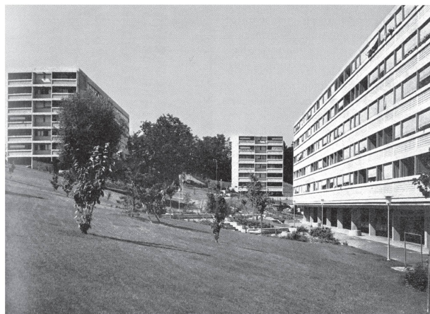
1 Quartier de l'Ancien-Stand, 1963-1965, chantier de l'immeuble sud, dont le gros-œuvre a été assemblé en 44 jours entre novembre 1963 et mars 1964 (Habitation 36, 1964, 7, p. 29).
