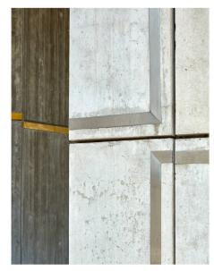
**6abc** Le dessin des joints négatifs de tailles variables crée un jeu d'ombre et de lumière dynamique que viennent colorer par touches linéaires les bandes de céramique. Les incrustations métalliques, placées sur le pourtour extérieur du bâtiment, animent et dynamisent les surfaces mates du béton (photos Jeremy Bierer, 2019).
