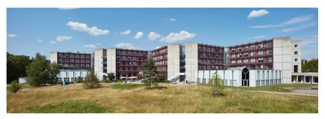
L'enveloppe du BFSH2 se compose de murs pignons en panneaux de béton préfabriqués, galonnés de bandeaux d'inox, qui encadrent les douze façades-rideaux devant lesquelles passent des coursives. Ces vastes surfaces vitrées dispensent ainsi un éclairage naturel maximal dans les bureaux et les salles de cours, les espaces de circulation intérieure et la cafétéria du rez-de-chaussée inférieur.
