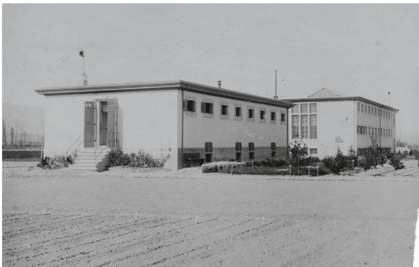
5 La prison centrale (ECA 1984), premier bâtiment du site encore existant construit par les architectes Corbaz & Centurier en 1897. La toiture était plate à l'origine. Au second plan apparaît une aile du bâtiment cellulaire, dont la toiture était également plate. (ACV KVII d 107).
