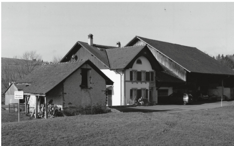
2 Au Grenet, commune de Forel. La ferme basse du XVIII e siècle a vu son logement agrandi en 1837 par un pignon transversal. La grange a été refaite vers 1960 (ACV, photo Claudine Glauser).
