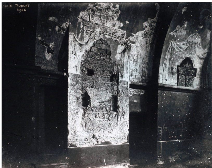
4 Les structures maçonnées servant d'adossement aux monuments funéraires bernois et leurs décors peints sur la paroi nord du chœur (XVIII e siècle). État lors de leur découverte en juillet 1925, avant leur destruction (ACV, AMH A 117/1, A 8981).
