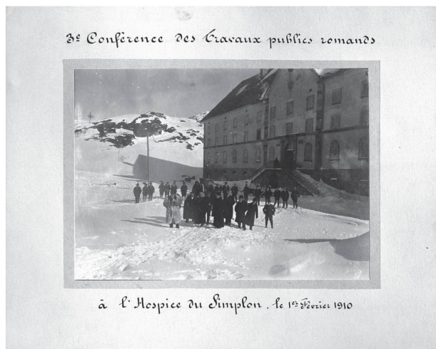
4 Troisième Conférence des Travaux publics romands à l'Hospice du Simplon, 1 er février 1910 (ACV, SB 285/0.08/2).
