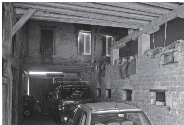
14 Orbe, Montchoisi, vue d'ensemble de la paroi orientale de la grange et de la fourragère prise en direction de l'est (photo Luigi Napi, 2013).
