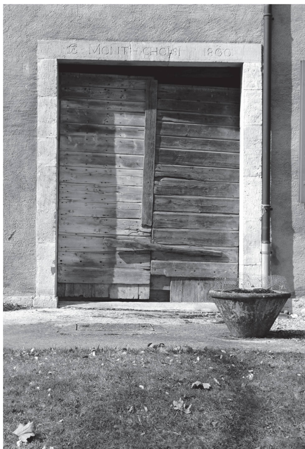
3 Orbe, Montchoisi, porte de la fourragère à linteau gravé (photo Luigi Napi, 2013).
