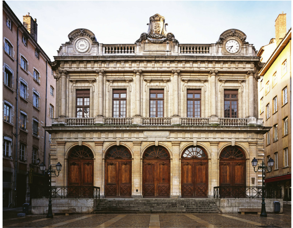
10 Façade de la loge du Change à Lyon, par Jacques-Germain Soufflot (Centre des monuments nationaux, photo David Bordes).
