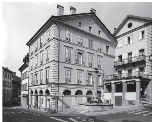
1 Les immeubles rue Saint-Bernard 1 et 3 constituent, avec la fontaine de 1835, le point fort du carrefour. Les façades reconstruites en 1837 sont caractéristiques du style de l'architecte Henri Perregaux. À gauche, le bâtiment abritant la pharmacie donne sur la rue Grenade, mais l'entrée aux étages se fait par le péristyle précédant la maison rue Saint-Bernard 3 (photo Claude Bornand, 1990).
