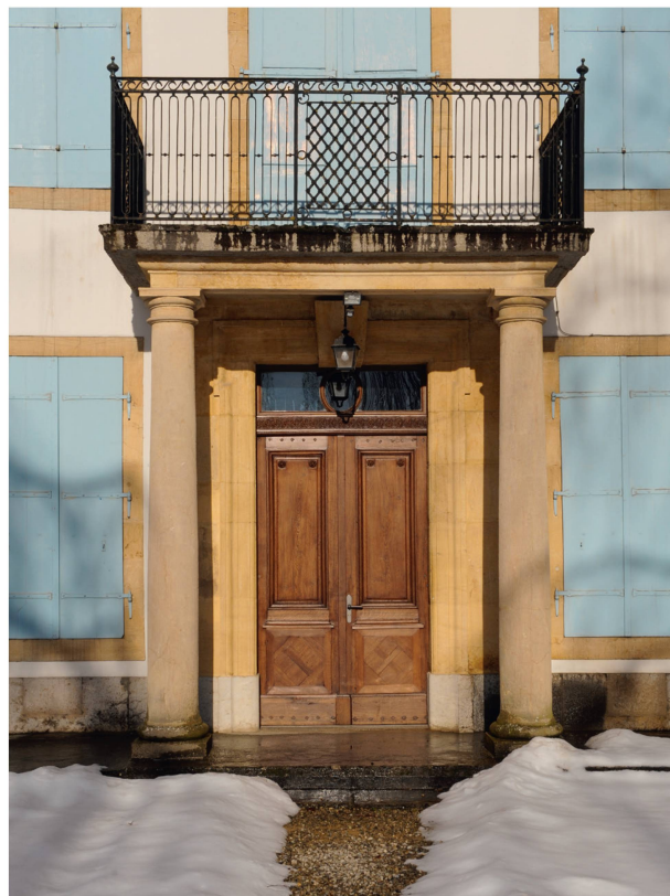
32 Cheseaux-Noréaz, maison de Champittet, entrée principale sur la façade occidentale (photo Daniel de Raemy).
