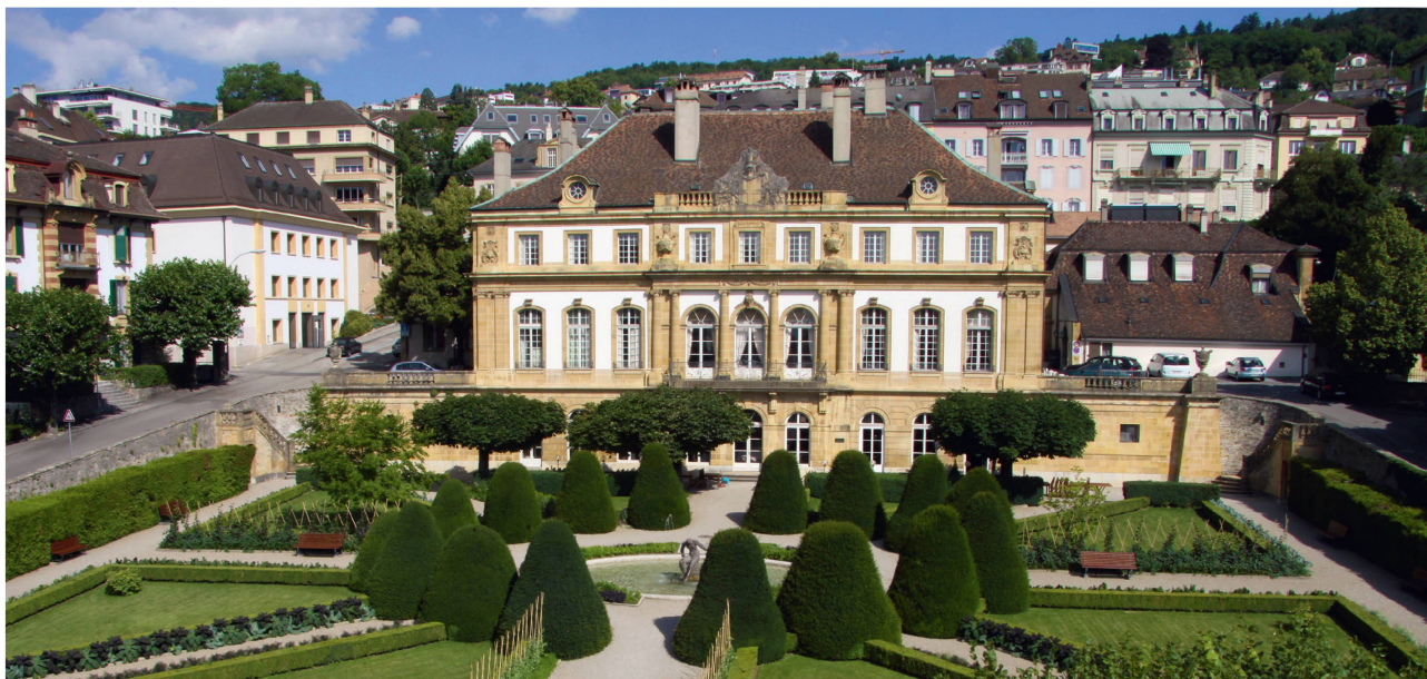
33 Façade principale de la maison DuPeyrou à Neuchâtel (photo Thierry Petit, 2011).
