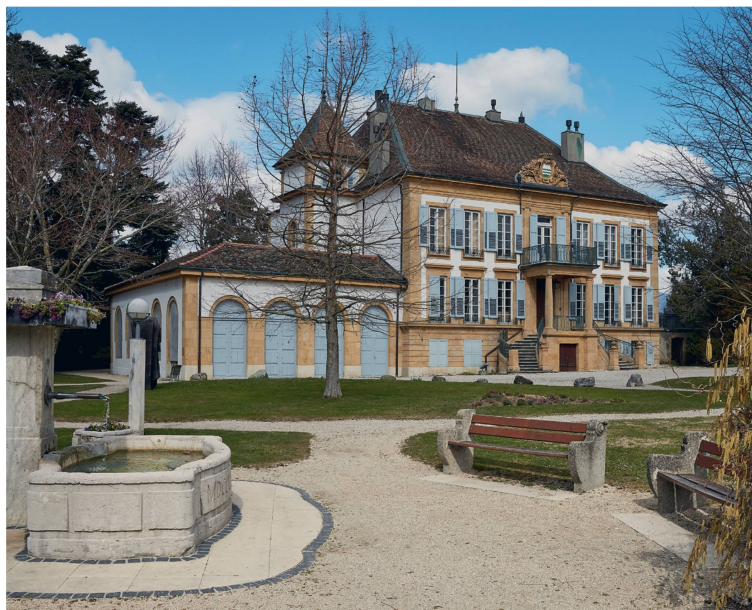
1 Ancienne maison Treytorrens, puis villa d'Entremonts, vue générale du site. Au premier plan, la fontaine de 1778, commandée par les Treytorrens au début de la grande reconstruction de leur domaine des Bains (photo Jeremy Bierer).
