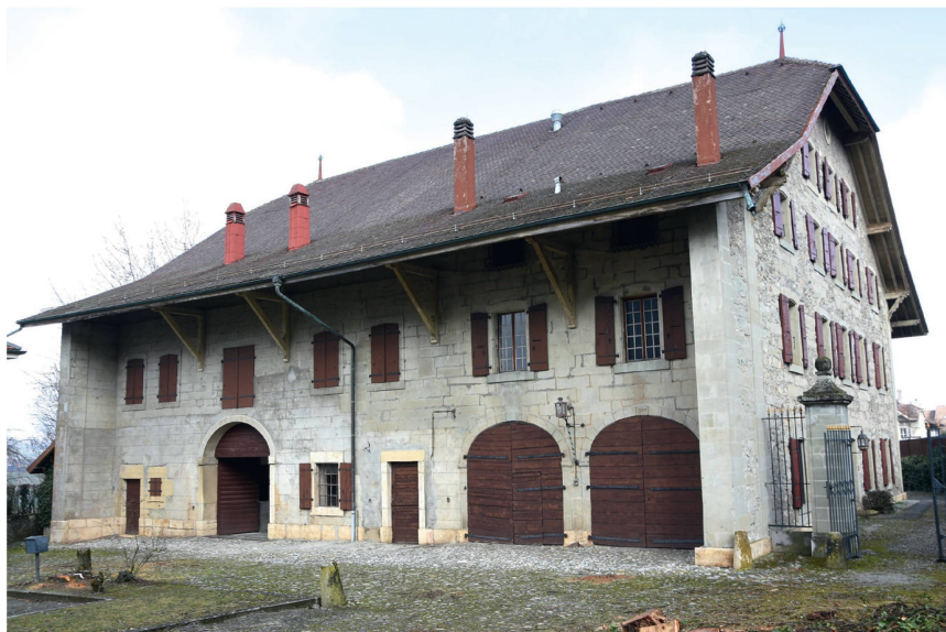
13 La grange et écuries rebâtie en 1779-1780, probablement selon les plans de l'architecte Gabriel Delagrangé; façade sud en pierre de taille soigneusement composée (photo Isabelle Roland, 2016).
