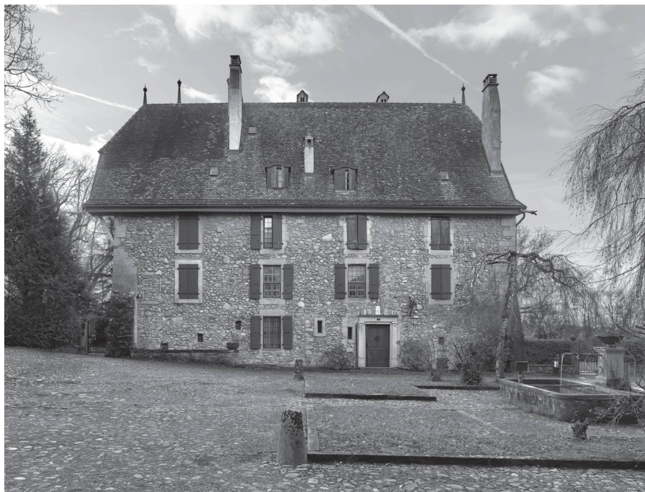
10 Façade nord avec la porte d'entrée créée en 1932-1933 avec des éléments en remploi (Rédaction MAH, photo Rémy Gindroz, 2015).
