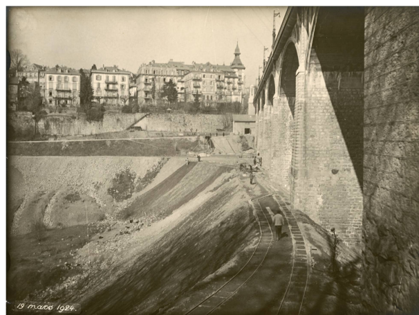
2 Chantier de terrassement en contrebas du pont Chauderon et le long de la rue de Genève. Photographie anonyme, 1924 (coll. du MHL).
