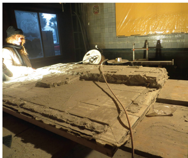
8 Le panneau «Pont sur la Verraye», prélevé, en cours de dégagement du matériel brique/mortier. Sur le mur à l'arrière-plan: le panneau «Temple de Montreux» après encollage des faïences, et pose d'un système de protection sur toute la surface (AM).
