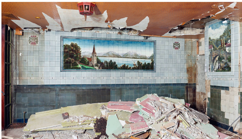
2 Le panneau du temple de Montreux sur le mur nord, à gauche de l'entrée, et le panneau du pont sur la Veraye. La suppression des aménagements du pub a révélé une conservation pratiquement intacte de l'ensemble du décor en faïence et en carreaux de ciment posés au sol et sur les murs. Les zones brun foncé témoignent de l'état des faïences avant nettoyage. Le tableau du temple est le seul à avoir pu être conservé in situ (© Rémy Gindroz, photographe).
