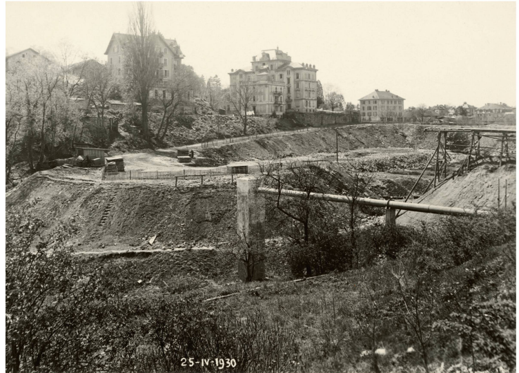
9 Rampe d'accès à la zone de comblement et de dépôt des matériaux de décharge avec installations de « pontonnage » ; en arrière plan, immeubles aujourd'hui démolis au bas de l'avenue Tivoli. Photographie André Kern, 1930 (coll. du MHL).
