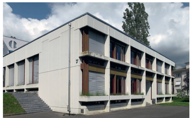
3 Lausanne, école du Riolet, chemin du Riolet 12, façades sud et ouest (photo B. Santos, 2016).
