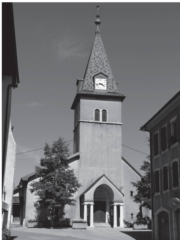
3 Clocher-porche, état actuel (photo G. Curchod, 2015).
