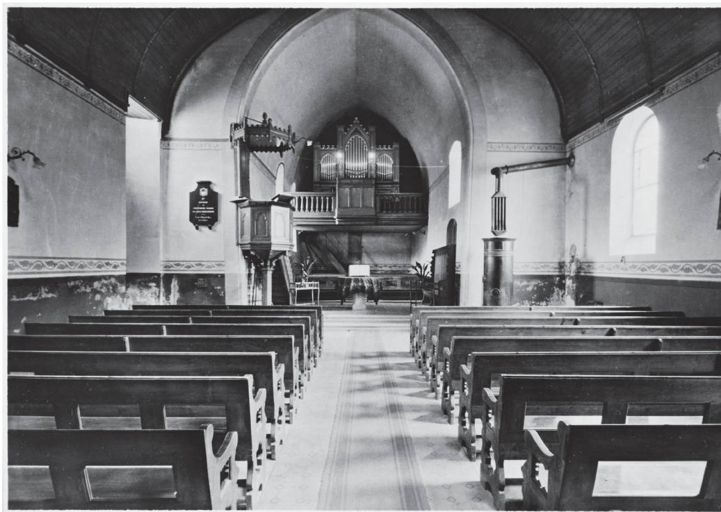
4 Photographie de la nef avant restauration, 1942 (© Rémy Gindroz, ACV, AMH A 28/5a).
