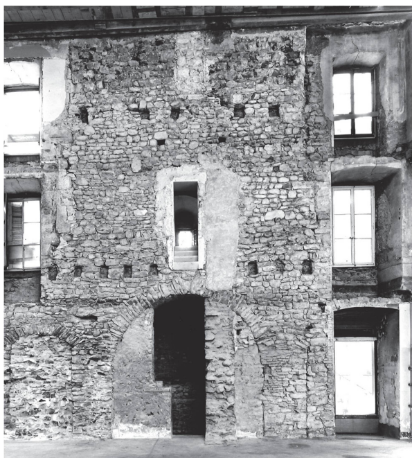
2-3 Maçonneries dégagées lors de la démolition de l'ancien hôpital en 1987. A gauche, face occidentale de la tour Saint-Jean : au rez-de-chaussée, partiellement ou entièrement murés, l'arc triomphal donnant accès à l'ancien chœur de la chapelle, flanqué de baies en arc surbaissé. Ci-dessus, après dégagement, l'ancien chœur de la chapelle Saint-Jean et sa niche latérale nord (photos Fibbi-Aeppli / Atelier d'archéologie médiévale, Moudon).
