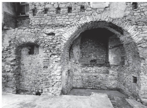
2-3 Maçonneries dégagées lors de la démolition de l'ancien hôpital en 1987. A gauche, face occidentale de la tour Saint-Jean : au rez-de-chaussée, partiellement ou entièrement murés, l'arc triomphal donnant accès à l'ancien chœur de la chapelle, flanqué de baies en arc surbaissé. Ci-dessus, après dégagement, l'ancien chœur de la chapelle Saint-Jean et sa niche latérale nord (photos Fibbi-Aeppli / Atelier d'archéologie médiévale, Moudon).
