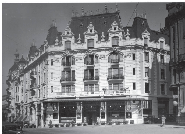
6 L'angle Terreaux-Mauborget vers 1940. La marquise a depuis été épaissie et une partie des ferronneries en toiture a disparu (© MHL, photo Jechiel Feldstein).
