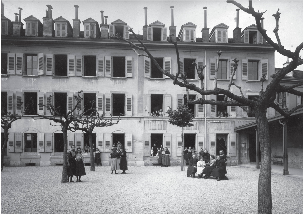
14 L'école Vinet peu avant 1898. Les façades des bâtiments rue Mauborget 6 et 8 présentent aujourd'hui la même partition en quatre travées à l'est et six travées à l'ouest. Il pourrait donc s'agir des mêmes bâtiments, abaissés d'un niveau et surélevés d'un étage (© MHL).
