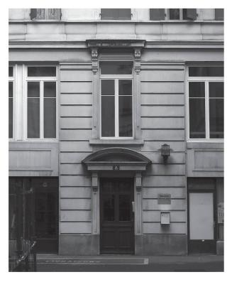
12 La porte d'entrée de la rue des Terreaux 8. Avec l'abaissement du sol en 1935, la porte d'entrée d'origine devient une fenêtre au 1<sup>er</sup> étage, alors qu'une nouvelle porte est créée dans l'ancien sous-sol avec un encadrement rappelant le style du début du siècle (photo Mathias Glaus, 2013).
