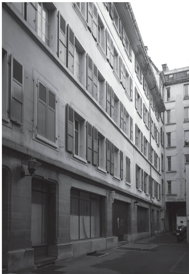
12 La porte d'entrée de la rue des Terreaux 8. Avec l'abaissement du sol en 1935, la porte d'entrée d'origine devient une fenêtre au 1 er étage, alors qu'une nouvelle porte est créée dans l'ancien sous-sol avec un encadrement rappelant le style du début du siècle (photo Mathias Glaus, 2013).
