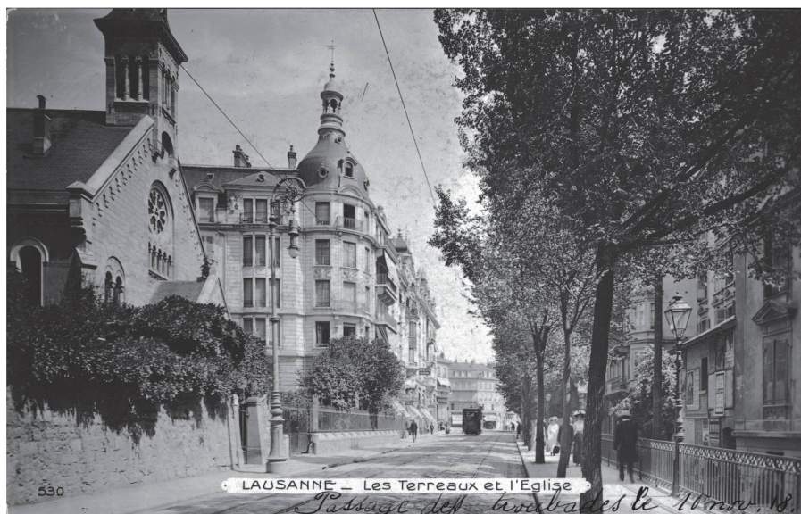
8 La rue des Terreaux vers 1918. Grâce au retrait des alignements, la rotonde rue des Terreaux 10 agit comme monument-cible depuis la place Chauderon. A gauche, la chapelle des Terreaux (© MHL).
