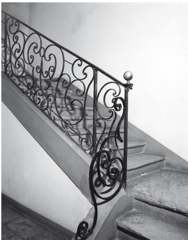
7 Balustrade de l'escalier (Photo Jean-Marc Biner).
