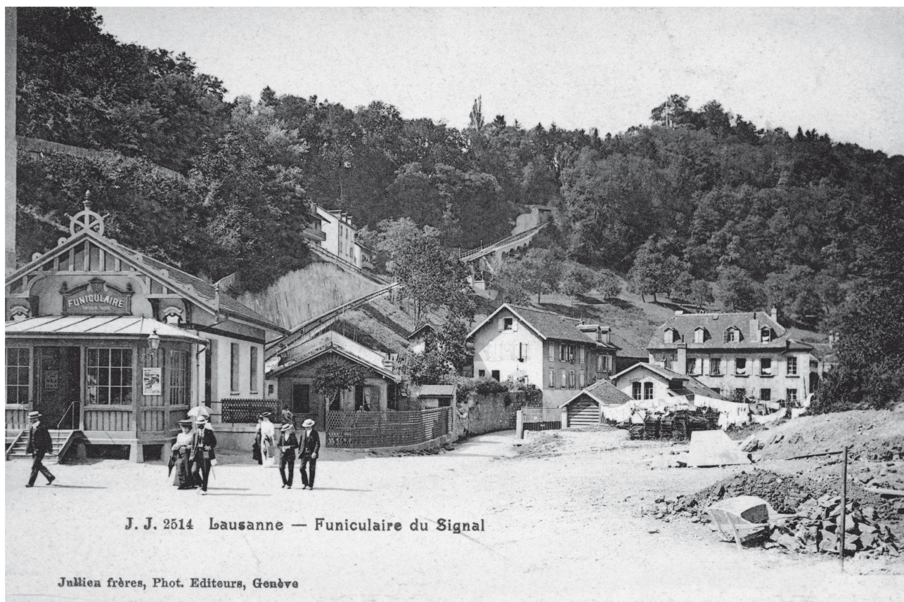
3 Carte postale de la place du Vallon vers 1900. De gauche à droite, la station de départ du funiculaire Lausanne-Signal avec la véranda de la salle d'attente, le buffet et sa terrasse, les bâtiments appartenant à la fonderie Duvillard. Dans la pente, on distingue le pont métallique et le viaduc du funiculaire, ainsi que les maisons de Montmeillan (© Musée historique de Lausanne, Jullien frères, photographes et éditeurs).
