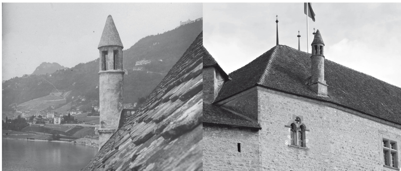
5 Cheminée du château de Chillon, bâtiment U2, vue de l'est à la fin du XIX e ou au début du XX e siècle et vue du lac en 2011 (Photo A. Naef, ACV, Archives du château de Chillon, A/4/168; Photo R. Gindroz, O. Feibl – Archéotech SA).
