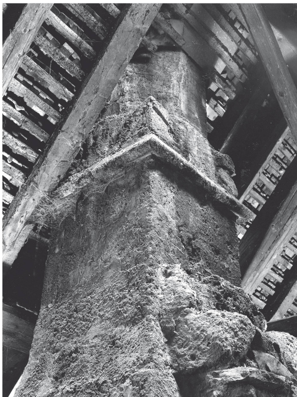
3 Lutry, rue du Bourg n° 6. Comble, souche de la cheminée gothique à base de plan carré, avec un larmier surmonté aux angles d'amortissements en crochets, puis octogonal (Photo C. Bornand – Archéotech SA).
