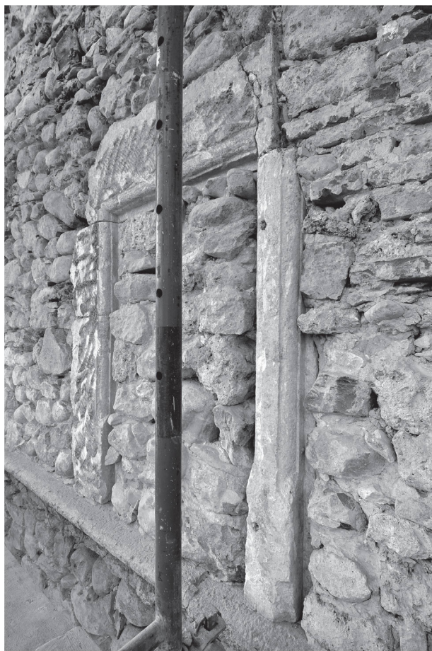
5 Cure de Chavornay, façade orientale. Fenêtre double à meneau de l'étape 2, dont ne sont conservés que le piédroit méridional, le meneau et le cordon entre les étages formant tablette (A. Jouvenat-Muller – Archéotech SA).
