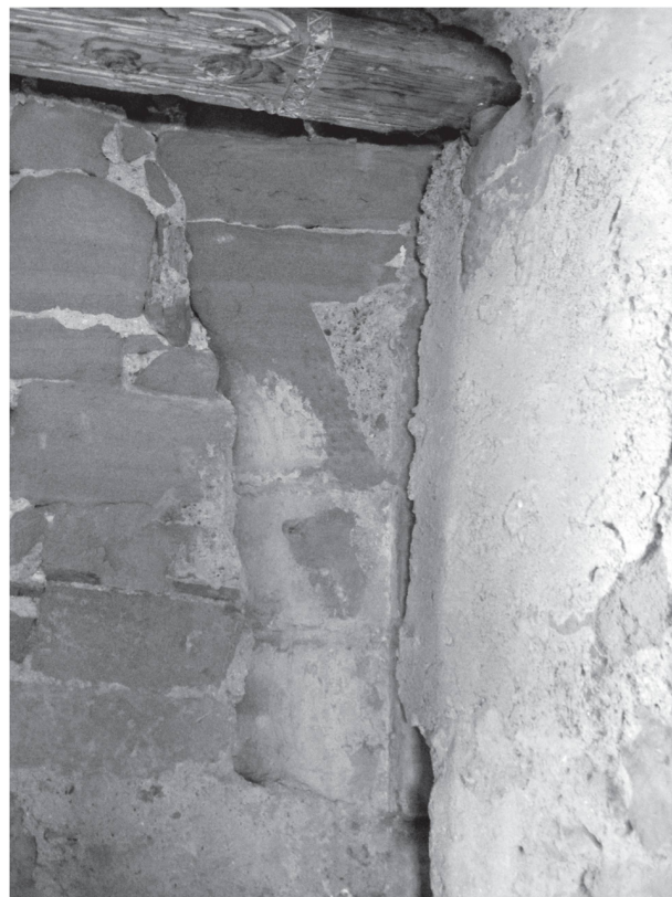
3 Rez-de-chaussée, angle nord-est: détail de la première colonne appartenant au système d'arcades ouvertes sur la rue à l'origine. Vue vers le nord (Photo Ph. Jaton, Moudon).
