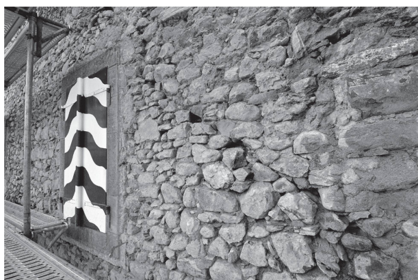
6 Cure de Goumoëns-la-Ville, façade sud-ouest. À droite de la fenêtre (1832), maçonnerie supposée du XIV e siècle avec la pente du toit et, au-dessus, maçonnerie du XVI e siècle (A. Jouvenat-Muller – Archéotech SA).
