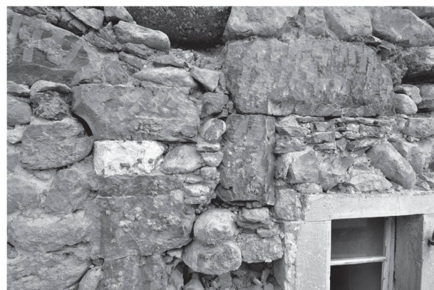
4 Cure de Chavornay, façade occidentale. À gauche, piédroit sud de la porte primitive à encadrement de blocs de molasse décorés d'un large chanfrein qui présentait, sous les blocs qui forment corbeaux, deux blocs de calcaire jaune pâle, probablement à but décoratif; de la fenêtre, de petites dimensions, également à encadrement de molasse avec une légère gorge et des arêtes arrondies, ne subsistent que le linteau et une partie du montant septentrional (A. Jouvenat-Muller – Archéotech SA).
